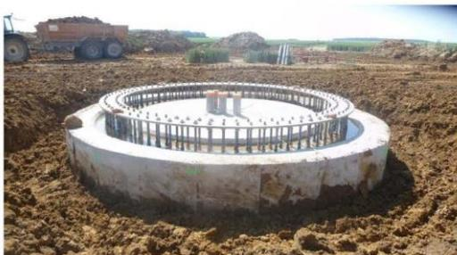
Le béton, en soit, ne pose pas de problème importants vis-à-vis de la ressource en eau souterraine mais les terrassements préalables et la mise en œuvre du béton par des camions « toupie » nécessiteront que des précautions soient prises.
